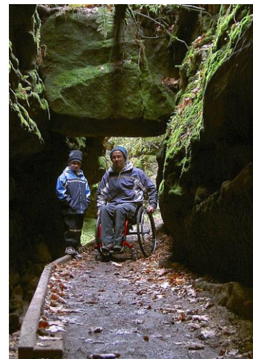
Wegverbreiterung am Felsentor im Uttewalder Grund
